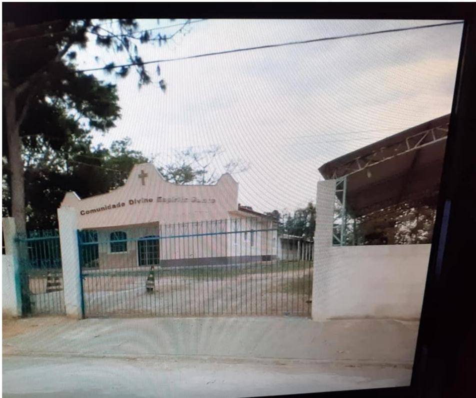
Arquitetura religiosa de formas simples, com nave única e um frontão bastante peculiar em comparação às capelas encontradas na região. A torre sineira forma-se de maneira escalonada, e o telhado é de duas águas, com telhas do tipo francesas. A estrutura é de madeira, com alvenaria de tijolos.
