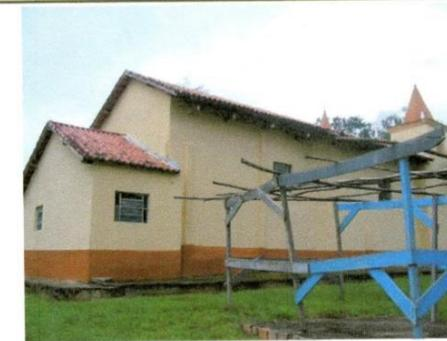
A arquitetura religiosa da Capela de São Sebastião é marcada por sua simplicidade, com uma nave única e altar separado, apresentando um frontão em tímpano triangular. Seu telhado de duas águas é coberto por telhas capa e canal, e a estrutura é composta por madeira e alvenaria de tijolos. Destacam-se também as torres nas duas laterais da capela.
