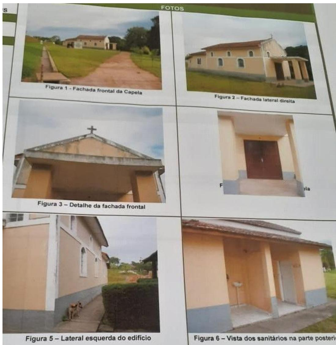
A arquitetura religiosa de forma simples, planos regulares, sem volumetria complexa, nave única com altar separado, sem cúpula com telhado de duas águas, frontão com tímpano triangular, em alvenaria de tijolos. A construção EM 2012 apresentava bom estado de conservação.
