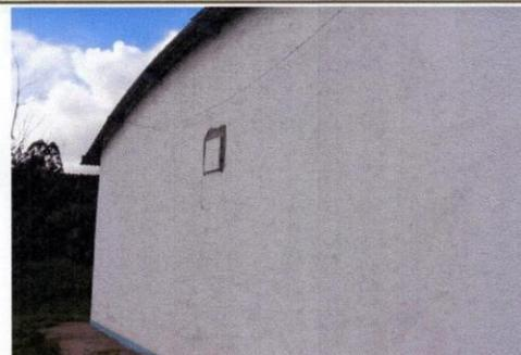
A arquitetura religiosa de forma simples, nave única, telhado de duas águas com telha e estrutura metálica, alvenaria de tijolos. Tem torre sineira no centro de sua fachada frontal.
