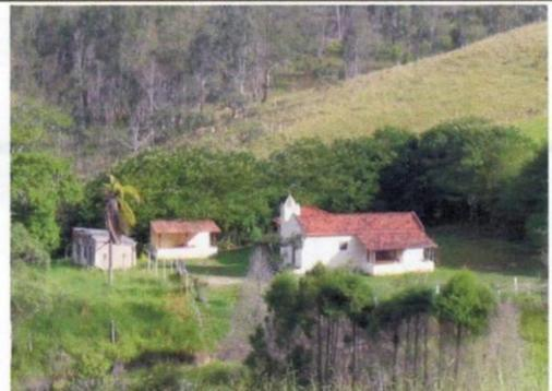
A Arquitetura religiosa de formas simples, nave única, frontão em tímpano triangular, telhado de duas águas com telha capa e canal, estrutura de madeira, alvenaria de tijolos. Torre sineira na lateral esquerda. Em 2012 a construção apresentava regular estado de conservação e em local privilegiado.
