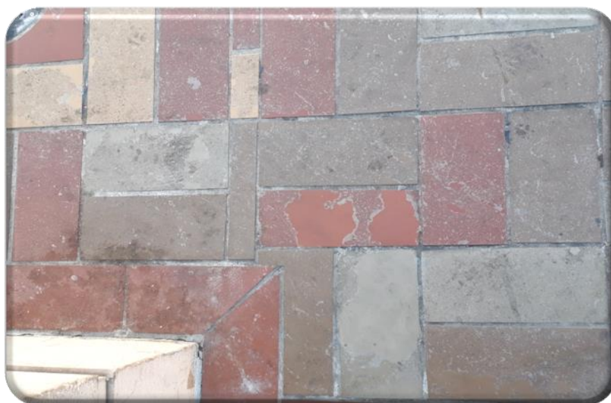
Figura 12: detalhe do revestimento de resina aplicada sobre o piso.
